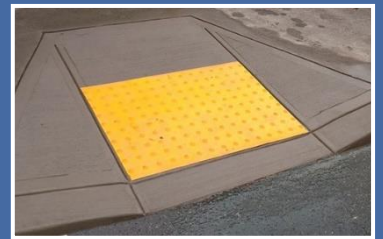
LAVADO A ALTA PRESIÓN PARA RAMPAS ADA
